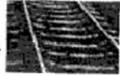
D. 铁轨铺设枕木
